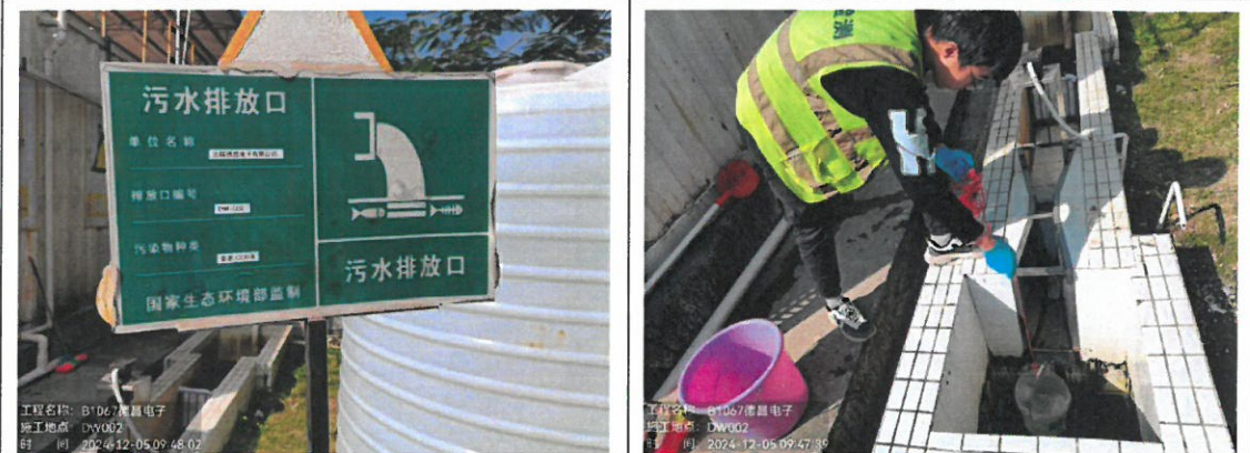
污水排放口 DW002 标志牌
